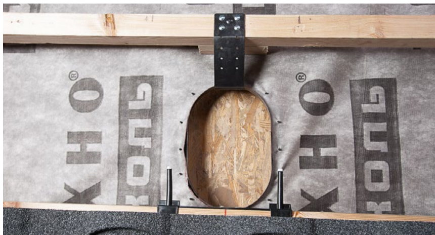
Рис. 39 а. Проходной элемент (UNIVERSAL) для панели Roman
