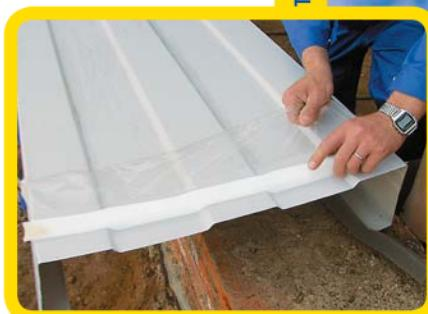
**2.** Снимите с сэндвич-профиля защитную пленку. В месте примыкания профиля к колонне наклейте на профиль уплотнитель УПКС
