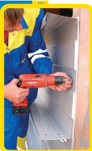
5. Следующий сэндвич-профиль МП СП ставится на верхнюю полку нижнего профиля и скрепляется саморезами Ø 4.2 x 16 (19) с ней (с шагом около 500 мм) и саморезами Ø 5.5 x 32 с колонной каркаса. Целесообразно вести монтаж сэндвич-профилей на всю высоту стены, чтобы после укладки теплоизоляции его можно было бы сразу закрыть ветрозащитой и облицовкой.
