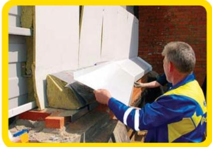
**11.** Установите ветрозащитный барьер (вариант А), закрепив его саморезами Ø 4.8 x 50 или временными проволочными скобами до зашивки облицовкой. Для варианта Б установите гидроветрозащитную мембрану и терморазделяющую полосу.
