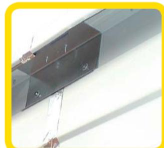
8. Установите элементы жесткости МП ЭЖ-100x96x3000 (МП ЭЖ-150x96x3000) внутрь сэндвич-профиля над и под оконными проемами на всю длину проема. Скрепите МП ЭЖ 100x96x3000 (МП ЭЖ-150x96x3000) саморезами Ø 5.5 x 32 с колонной каркаса, а саморезами Ø 4.2 x 16 (19) с сэндвич-профилем.
