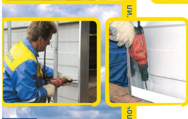
9. При устройстве дверных и опорных проемов используйте элемент обрамления МП ЭО-100x25x3000 (МП ЭО-150x25x3000) для придания жесткости раме вокруг проема в вертикальной плоскости. Перед установкой надрежьте МП ЭО-100x25x3000 (МП ЭО-150x25x3000) сверху и снизу и отогните на 90 градусов. Наденьте МП ЭО со стороны проема на сэндвич-профиль. В местах прилегания (полки и выпуклые гофры профиля) закрепите саморезами Ø 4.2 x 16 (19).
