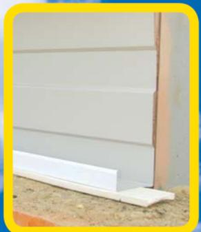
**3.** Установите начальный сэндвич-профиль (МП СПН) на уплотнитель цоколя и прикрепите его тремя саморезами Ø 5.5 x 32 (проходят без предварительного засверливания до 14 мм стали) к каждой колонне каркаса.
